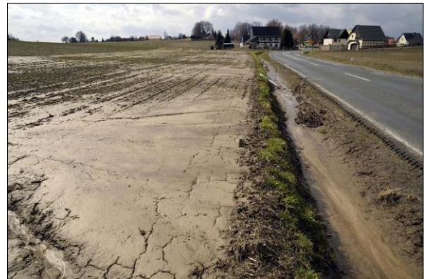
Abb. 49: Ackererosion durch Starkregen in Siedlungsnähe (Quelle: TLUG 2013)
