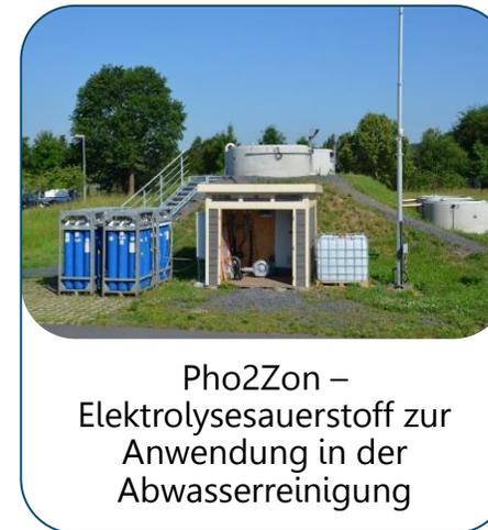
Pho2Zon – Elektrolysesauerstoff zur Anwendung in der Abwasserreinigung
